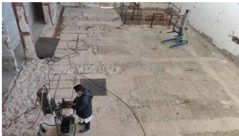
Figure 146: Caracterización de soleras en IN-04
